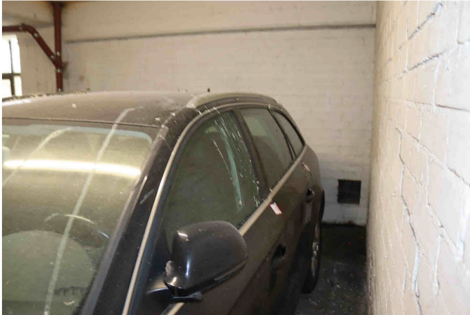
Bild 19 Starke Verunreinigung durch Vogelkot
